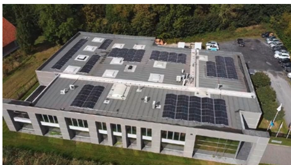
Závod spoločnosti Hach pre integrované systémové riešenia v Nazarete, Belgicko
